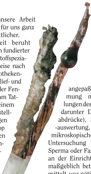
Kurzschluß: Erst mit Hilfe der Mikro-Fotografie und anschließender Begutach- tung des Bildes durch die Experten der Frankfurter Polizei wurde dieses Strom- kabel als Ursache für einen Hausbrand ausgemacht.
