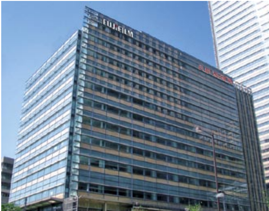
Auch äußerlich ist die Reorganisation bei Fujifilm sichtbar: Im neuen Hauptquartier sind neben der Holding auch die beiden operativen Unternehmen Fujifilm und Fuji Xerox untergebracht.
